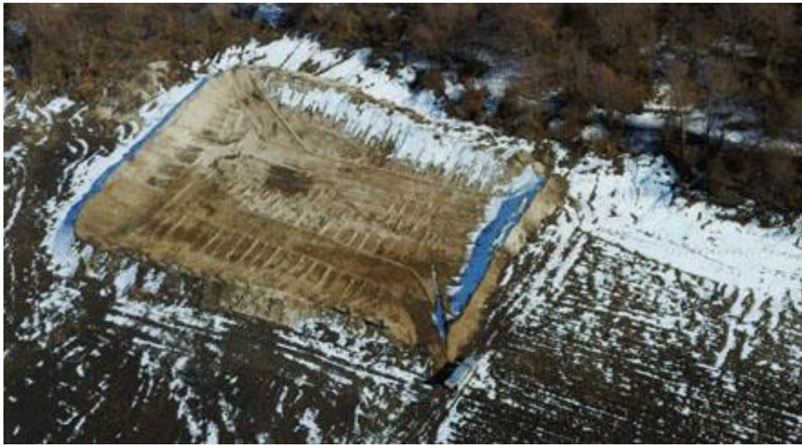
Рис. 2 - Строительство накопителя воды (съемка квадрокоптером)
